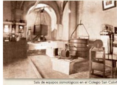
Sala de equipos sismológicos en el Colegio San Calixto
